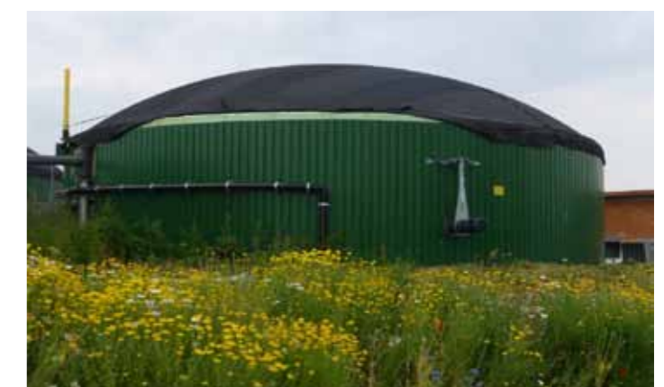
Abbildung 33: Biogasanlage Bäuerle in Kleinaspach
