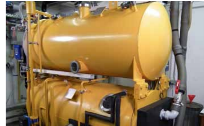
Abbildung 47: Absorptionskälteanlage AKA „Hummel“ für niedrige Temperaturen
