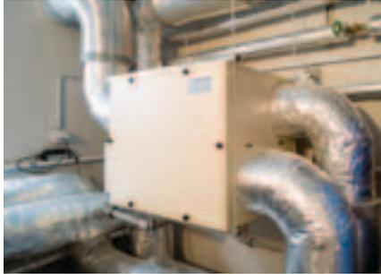
Abb. 58: Zu- und Abluftanlage mit Wärmerückgewinnung
