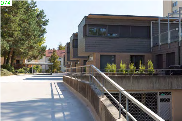
K Konstanz, Wohnen statt Parken (→ 19): Doppelnutzung von kostbarem innerstädtischen Baugrund und intelligentes Energiekonzept
