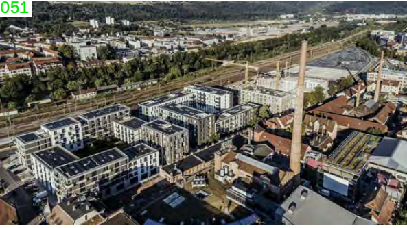
H Esslingen am Neckar, Neue Weststadt Klimaquartier (→ 9): Durch Integration innovativer Technologie nahezu klimaneutral
