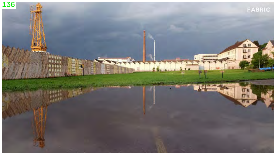
S Lörrach, FABRIC – Planung als Plattform (→ 22): Das Planungsgelände in Brombach – gute Ideen gesucht
