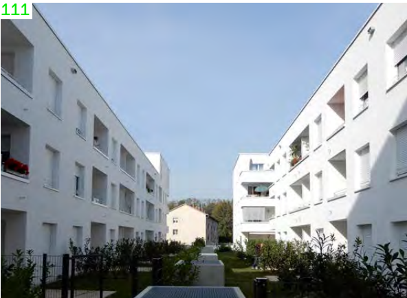
P Lahr, Sanierung Wohngebiet Kanadaring (→ 20): Die sanierten Gebäude der Wohnsiedlung aus den 1950er Jahren
