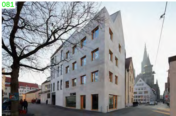
L Ulm, Wohn- und Geschäftshaus k5 (→ 33): Multifunktionaler Stadtbaustein statt Baulücke
