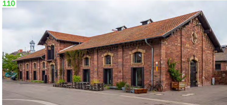
P Karlsruhe, Alter Schlachthof (→ 15): Alter Schweinestall – heute Büros
