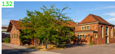
S Karlsruhe, Alter Schlachthof (→ 15): Ehemalige Kaldaunenwäsche
