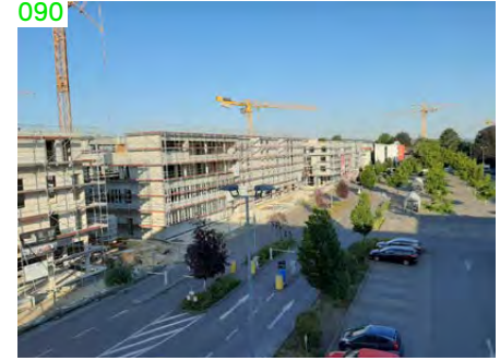
M Kirchheim u. T., Steingauquartier (→ 17): Baufortschritt (August 2020) – es entstehen ca. 200 Mietwohnungen mit preisreduzierten Mieten
