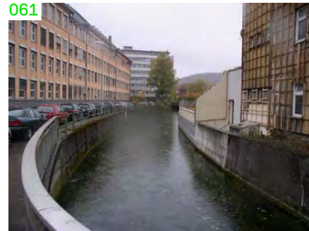
I Heidenheim an der Brenz, Ploucquet-Areal (→ 12): Die Brenz vor der Renaturierung
