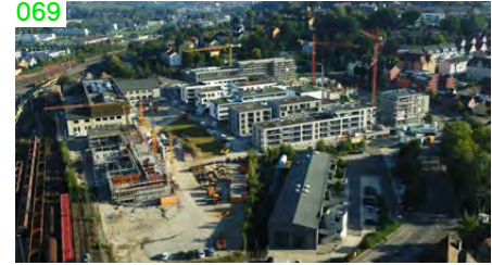
J Aalen, Stadtoval (→ 4): Der neue integrierte Stadtbaustein (2020)
