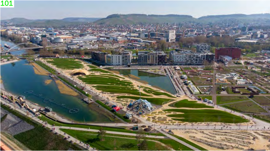
O Heilbronn Stadtquartier Neckarbogen (→ 14): Luftbild nach der Aufsiedlung
