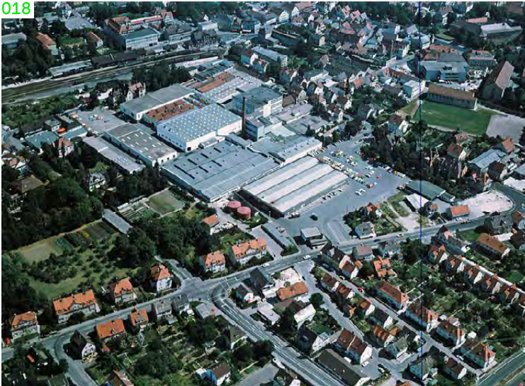
C Kirchheim u. T., Steingauquartier (→ 17): Ausgangssituation – Maschinenfabrik (1975)
