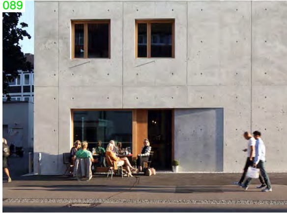
M Ulm, Wohn- und Geschäftshaus k5 (→ 33): Nutzungsmischung in einem Gebäude – Café, Büro, Wohnen
