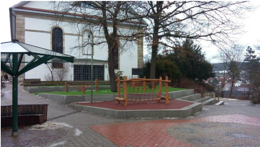
Abgeschlossene Pausenhofgestaltung an der Schlossschule Gomaringen, 1. Bauabschnitt
