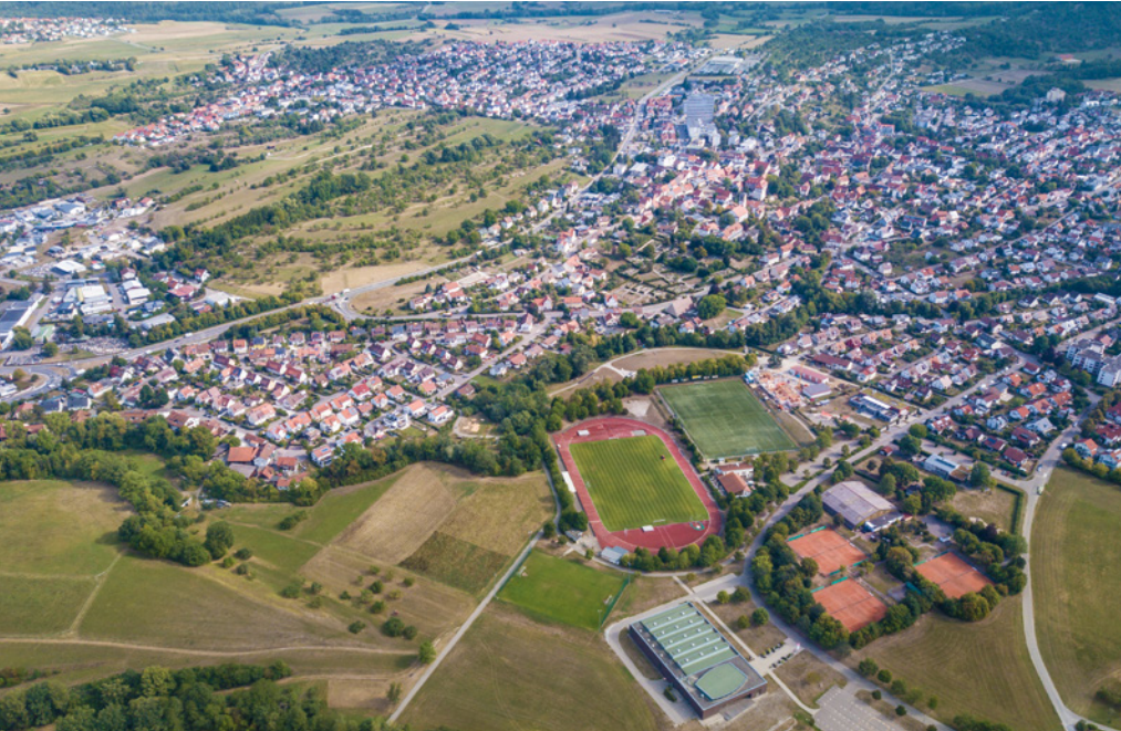
Blick von Süden; im Vordergrund die Sportanlagen
