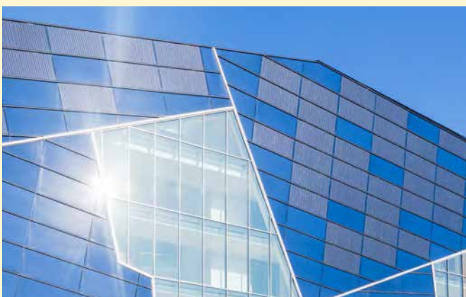
Solarfassade der Volksbank Karlsruhe
